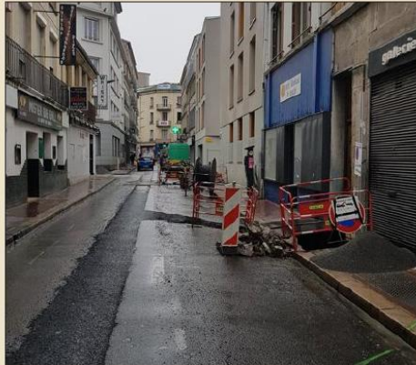
■ Début avril, les travaux se poursuivent rue Honoré-de-Balzac. Photo Sylvie JOURGET
